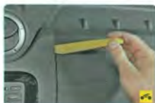
6. Подденьте монтажной лопаткой верхнюю накладку центральной консоли...
